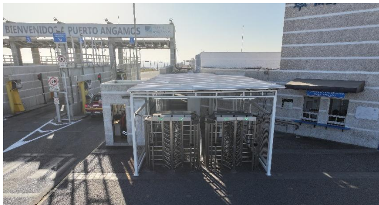
Acceso Principal Puerto Angamos (Torniquetes y Ventanilla)
